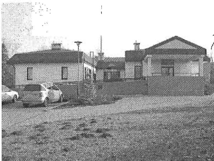
Fot. 3. Elewacja (tylna) zachodnia, z widokiem na patio.
