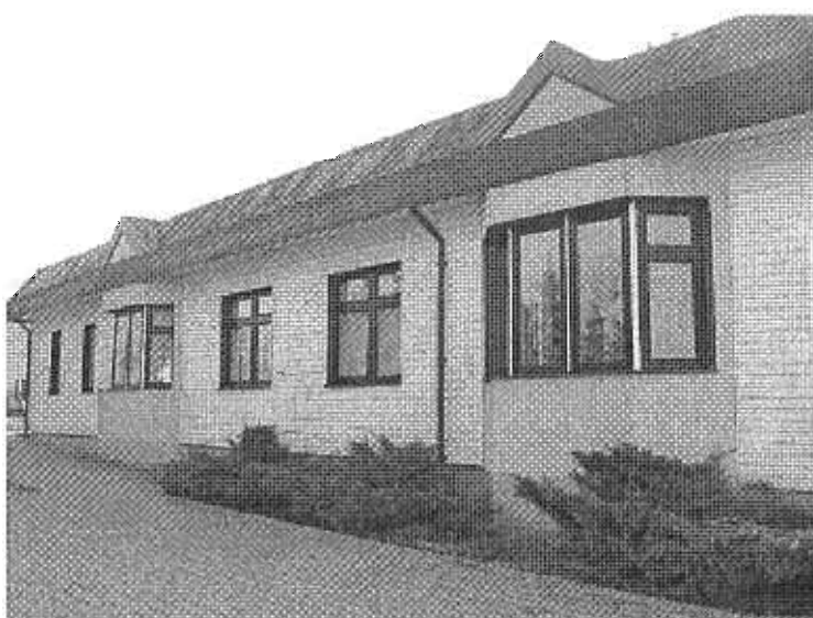
Fot. 4. Elewacja północna, z widocznymi wykuszami.
