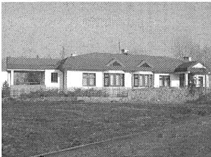
Fot. 2. Elewacja południowa, z widocznymi wykuszami.
