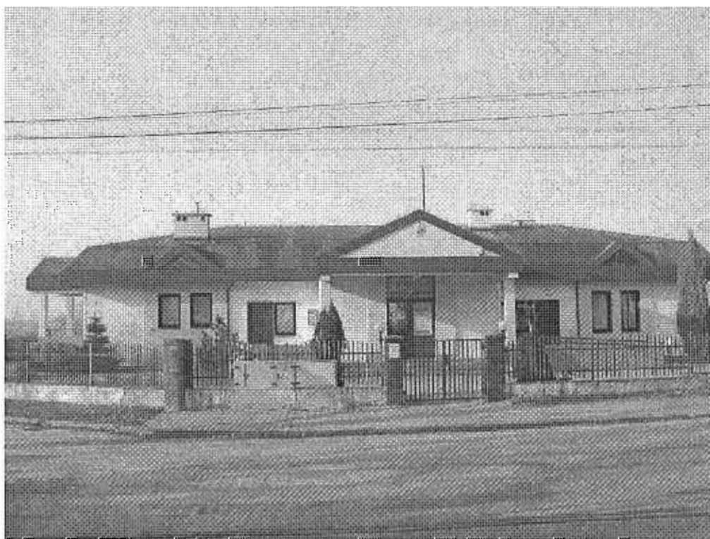
Fot. 1. Elewacja frontowa (wschodnia) budynku OZ w Mrokowie
