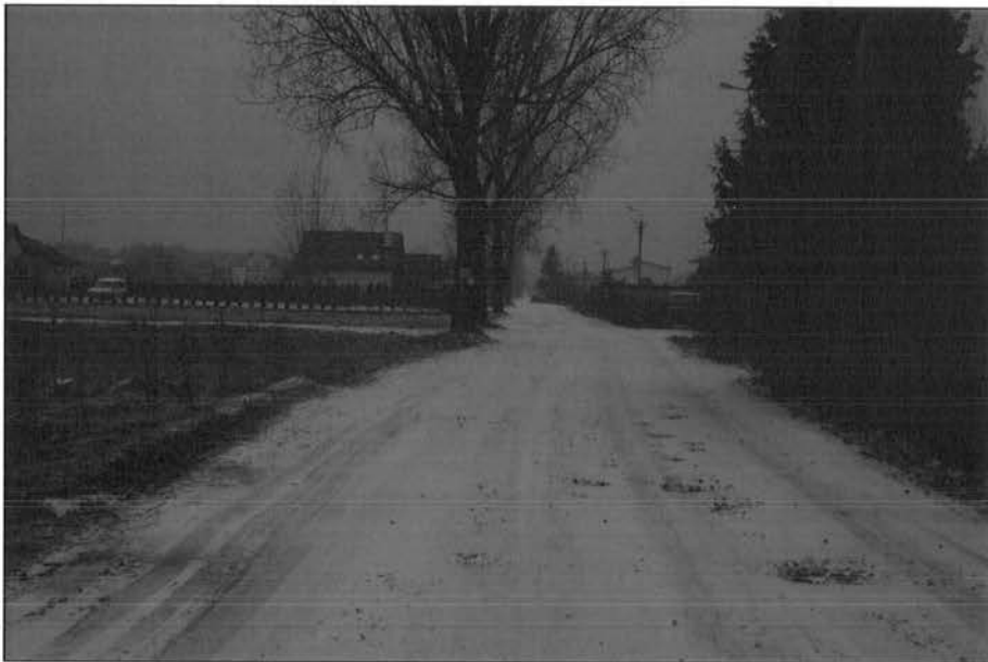
Fot. 2 Typowy przekrój drogi ul. Jasnej
