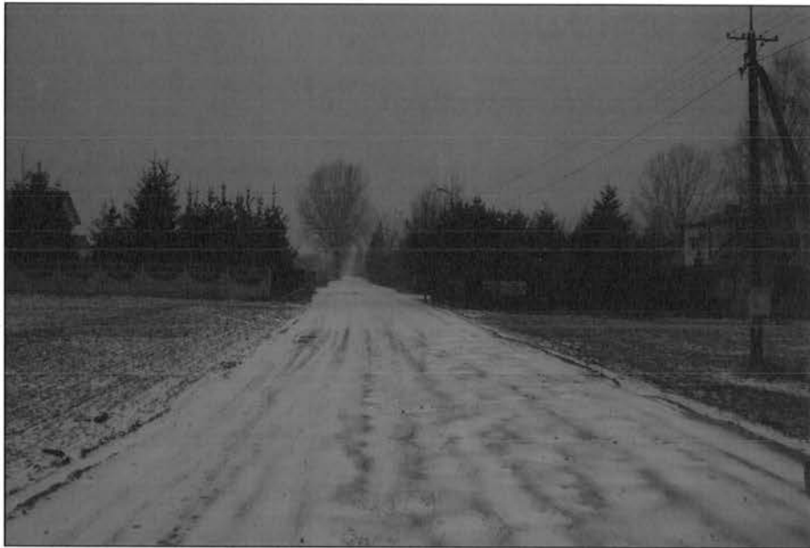
Fot. 1 Typowy przekrój drogi ul. Jasnej
