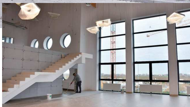
Prace wykończeniowe w Auli
