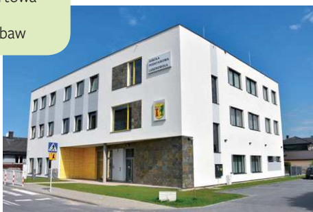
Budynek przy ul. Sportowej w Lesznowoli
