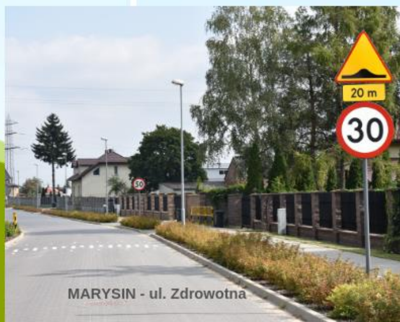
BUDOWA UL. GMINNEJ W LESZNOWOLI
