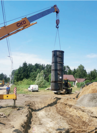
Budowa przepompowni w ul. Ułanów
