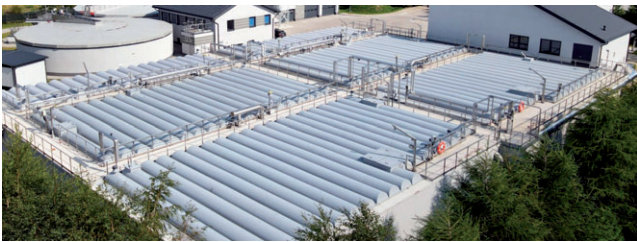
Obiekty biologicznego oczyszczania ścieków (komory biologiczne)
