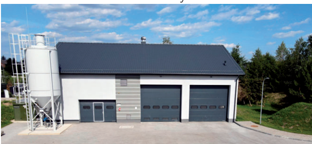
Obiekt odwadniania osadów ściekowych
