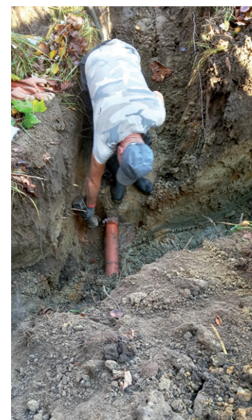
Czyszczenie drenów w Lesznówoli
