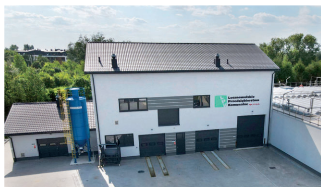
Obiekt mechanicznego oczyszczania ścieków
