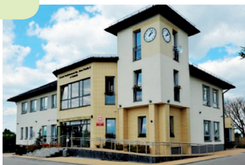
Budynek przy ul. Łączności w Łazach
