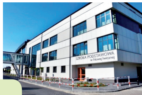
Rozbudowany gmach szkoły przy ul. I. Krasickiego 56 w Nowej Iwicznej
