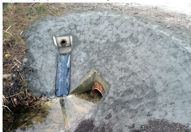
Naprawiony przyczółtek na rowie w Zgorzale
