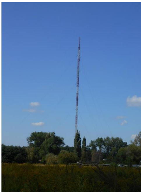
Fot. 8. Maszt nadajnika radiowo-telewizyjnego w Łazach, A. Pustowska, 2019 r.
