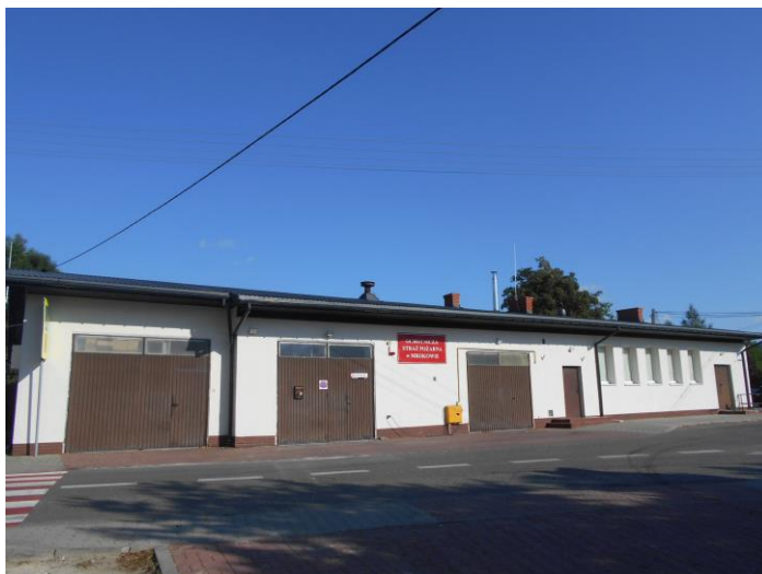
Fot. 7. Budynek Ochotniczej Straży Pożarnej w Mrokowie. A. Pustowska, 2019 r.
