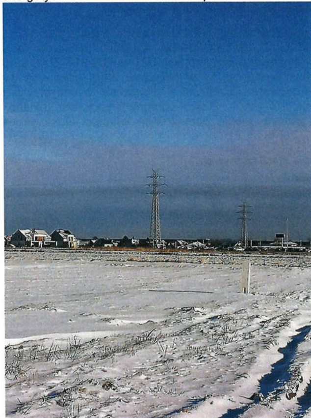
Rys. Linia elektroenergetyczna 110 kV na obszarze opracowania.
