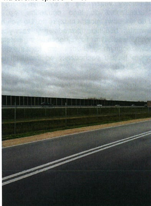
Rys. Droga ekspresowa S7 na terenie opracowania.
