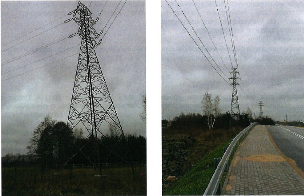
Rys. Linia elektroenergetyczna 110 kV na obszarze opracowania.
