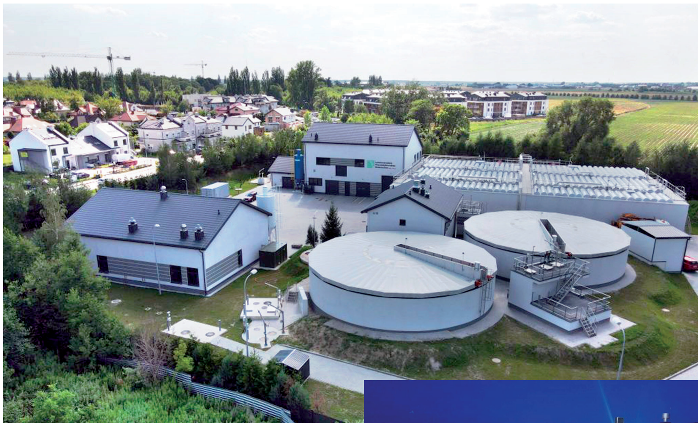
Obiekt oczyszczalni ścieków w Zamieniu
