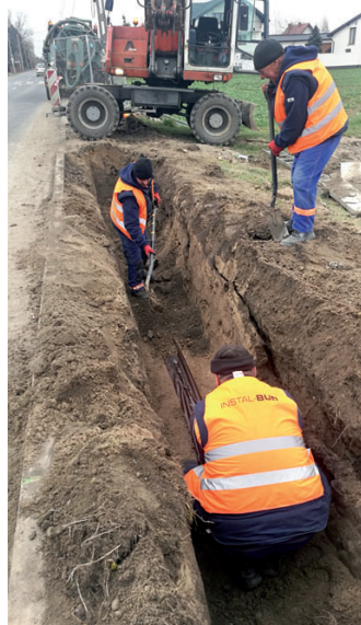
Budowa kanalizacji sanitarnej tłocznej (trasa Nowa Iwiczna i Nowa Wola) wraz z przepompownią ścieków
