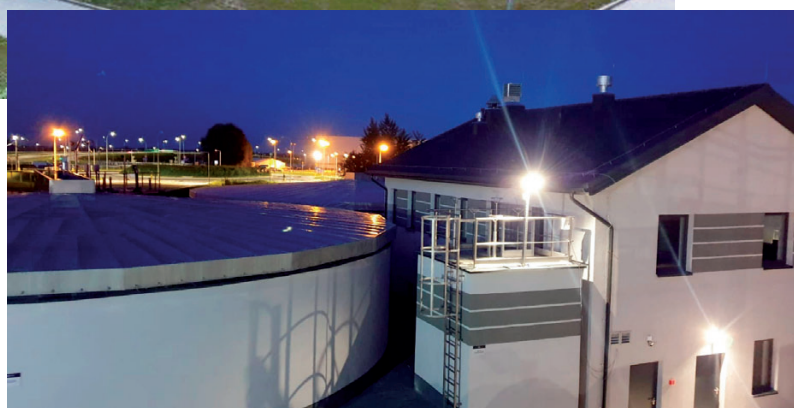
Budynek socjalny oraz osadnik wtórny
