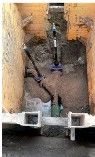
Budowa kanalizacji sanitarnej tłocznej (trasa Nowa Iwiczna i Nowa Wola) wraz z przepompownią ścieków
