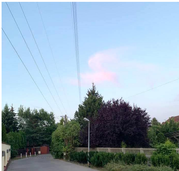
Fot. 3 Linia elektroenergetyczna 220 kV (źródło: „Opracowanie ekofizjograficzne (...)”)
