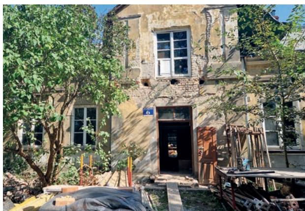
W trakcie remontu.
