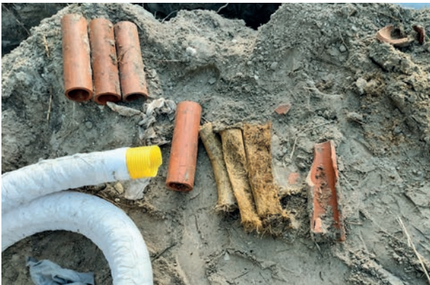
Naprawa zapchanych rur drenarskich w Woli Mrokowskiej.
