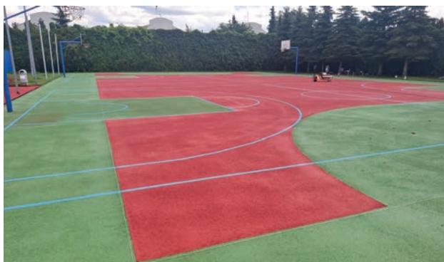
Nowa Iwiczna modernizacja boiska.
