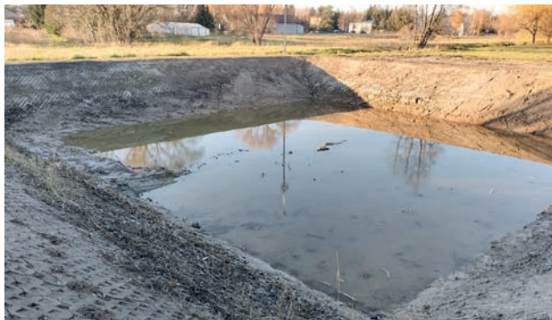
Staw w Mrokowie po wykonaniu prac.
