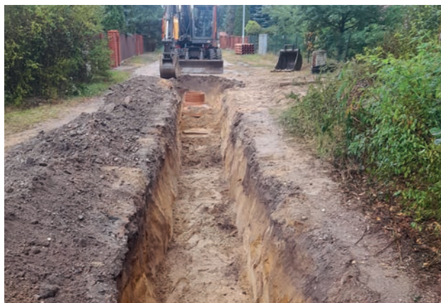
Budowa sieci wodociągowej w Stefanowie.
