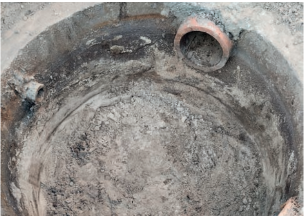
Oczyszczona studnia melioracyjna w Podolszynie.
